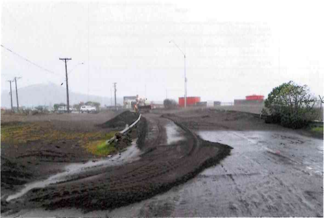
(Interrupción tránsito vehicular por arena en la vía, Caleta Lengua) Temporal junio 2024
