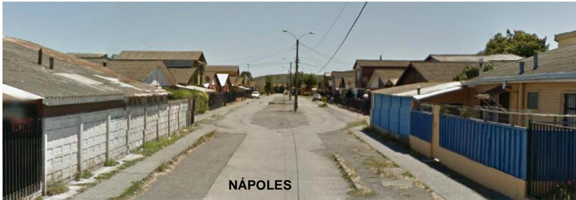
El pasaje tiene una longitud total de 1.500 m aproximadamente, mientras que el segmento estudiado tiene 140 m de longitud y un ancho entre líneas oficiales variable desde 10 m hasta 15 m. La materialidad de su calzada es de hormigón sin solera de 4 m de ancho, mientras que sus aceras son de pastelón con bandejón de tierra de 3 m de ancho.
