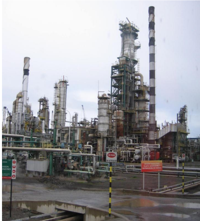
Cuadro N°21 Vista interior de ENAP Refinería Biobío.
