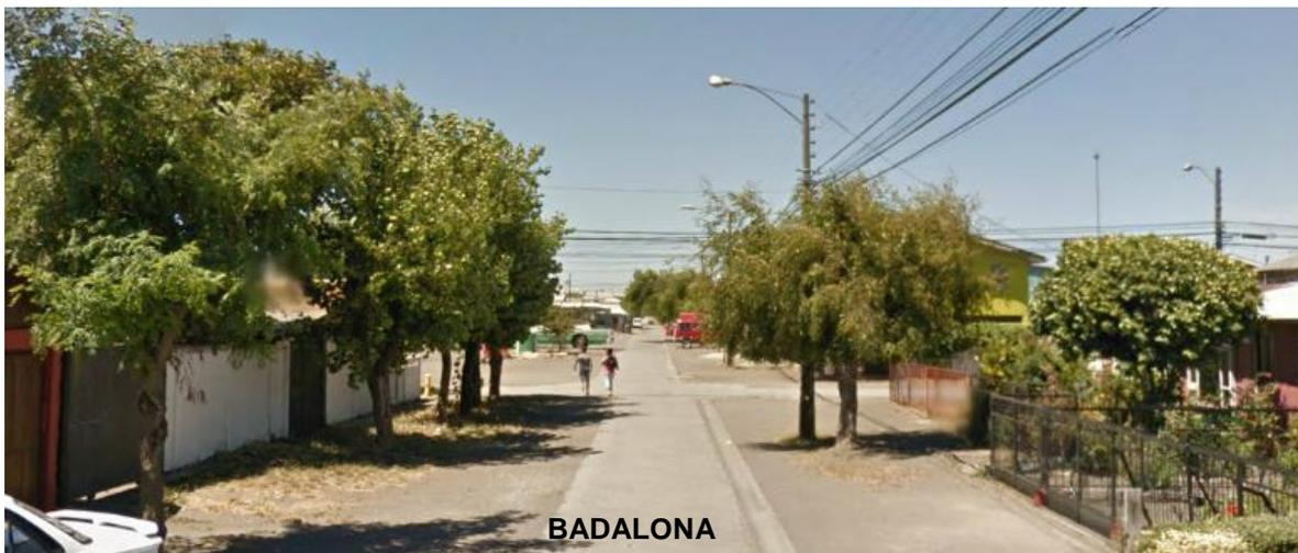
El pasaje tiene una longitud total de 660 m aproximadamente, mientras que el segmento estudiado tiene 340 m de longitud y un ancho promedio entre líneas oficiales de 14 m. La materialidad de su calzada es de hormigón de 3 m de ancho, mientras que sus aceras son de tierra de 5,5 m de ancho.
