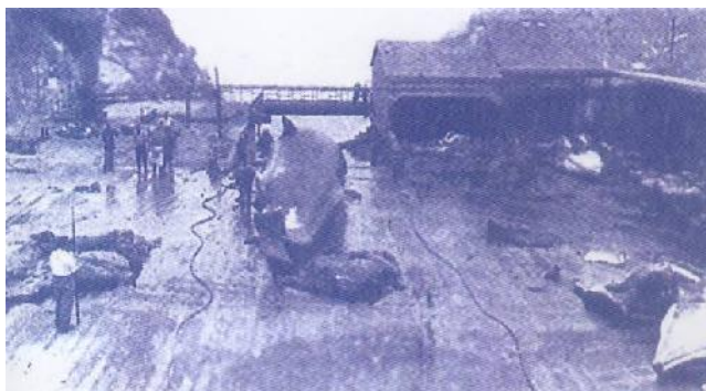
Planta Ballenera en funcionamiento 13
