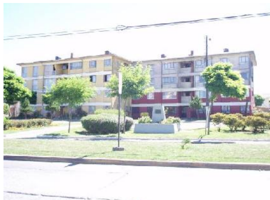
Edificios Villa Pdte. Bulnes por Colón
