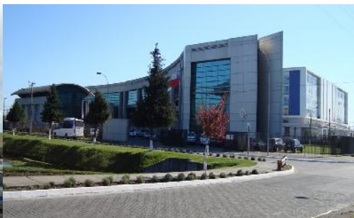
Edificio diario El Sur (Hoy Clínica Universitaria)
