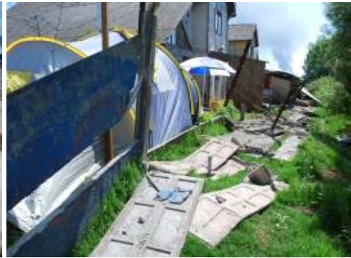
Daños en viviendas, muros de deslinde, etc.
