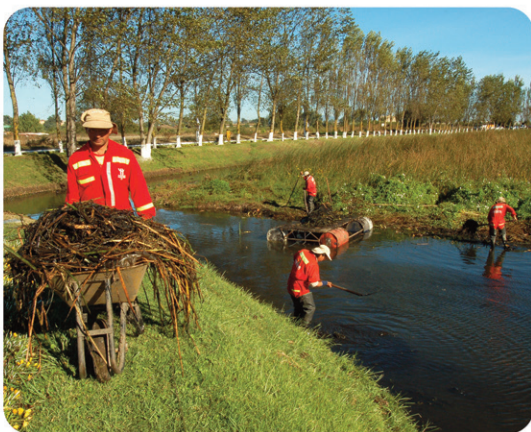
UN IMPORTANTE NÚMERO de cuadrillas trabaja arduamente limpiando el Canal Ifarfe, el que además posee una rica diversidad de flora y fauna.
